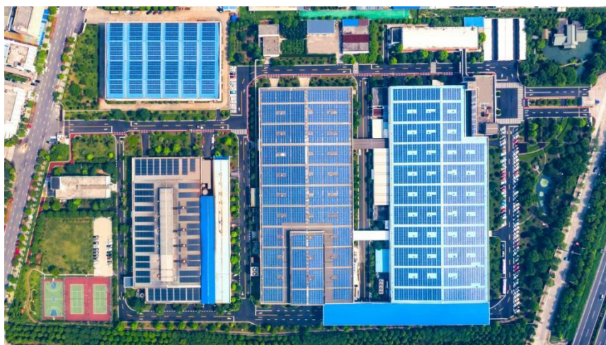
图：屋面太阳能光伏板
