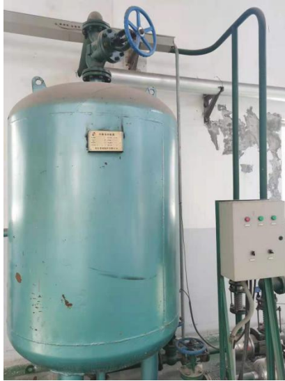
锅炉冷凝水回收装置
